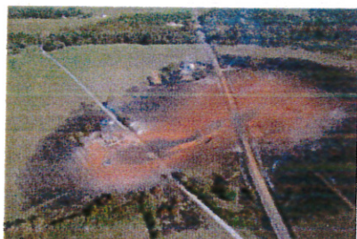
Conséquences d'une fuite sur une canalisation de transport, Appomattox (USA), 14 septembre 2008 (source US Trust Oil).
