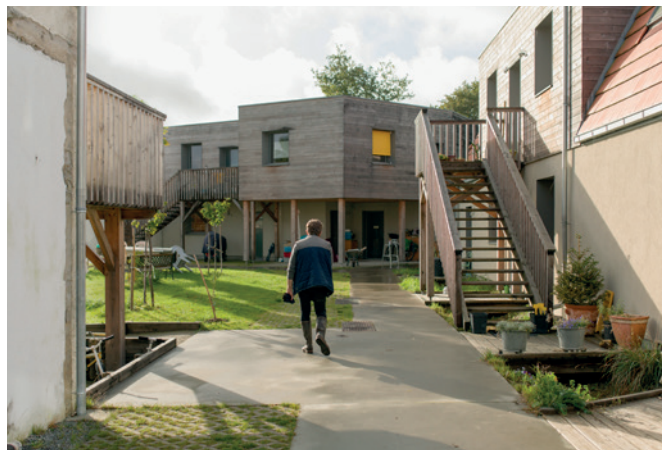
L'accès vers le coeur du hameau : traitement des cheminements et des sols en béton, pavés enherbés, seuils et accès différenciés aux logements, noues paysagères pour récupérer les eaux de pluie.
