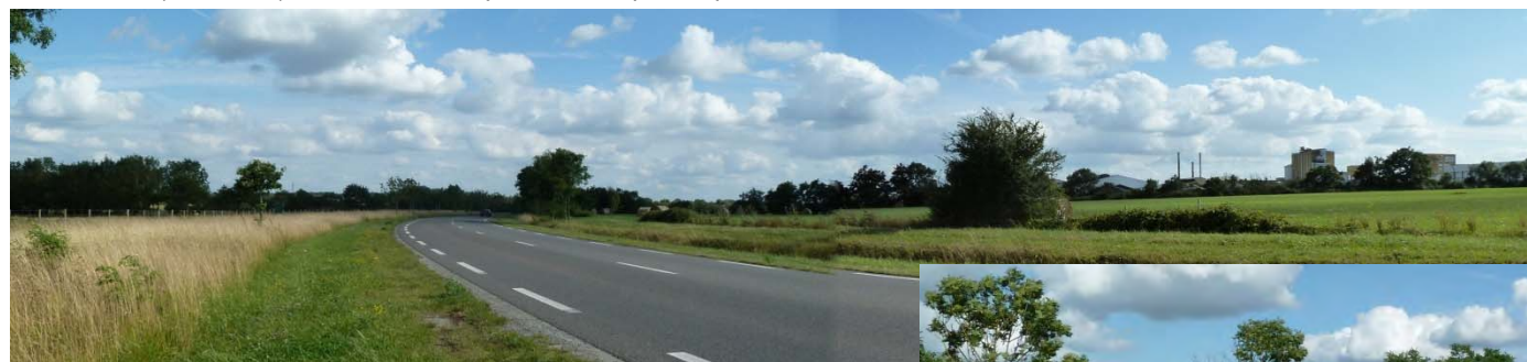
8 - La RD 723 (rocade Est) et la laiterie en point haut
