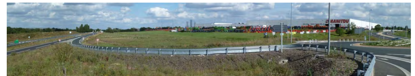
1 - La façade de Manitou sur le nouvel échangeur de l'Aubinière - la déviation (RD 723) en contre bas
