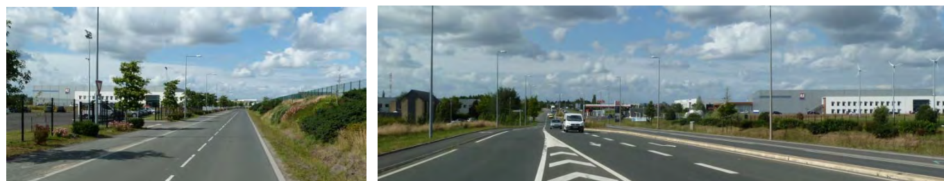
3 - Vue depuis l'A11 : l'usine Manitou et le site de La Savinière à l'approche du péage depuis Angers
