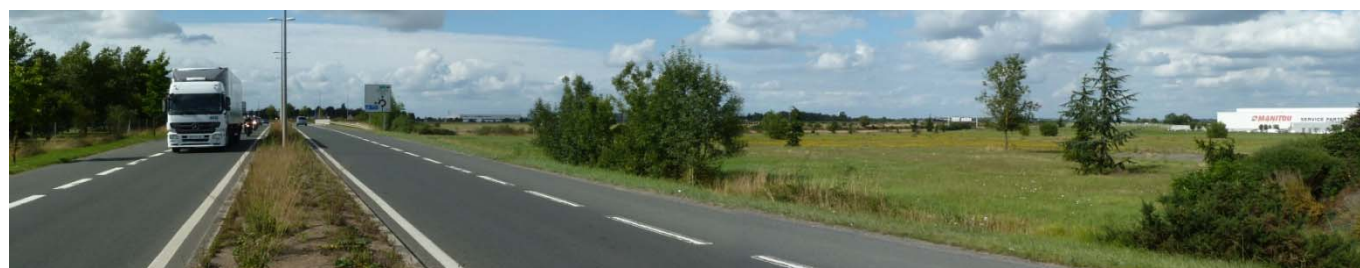
6 - Vue depuis l'A11 : l'usine Manitou et le site de La Savinière à l'approche du péage depuis Angers
