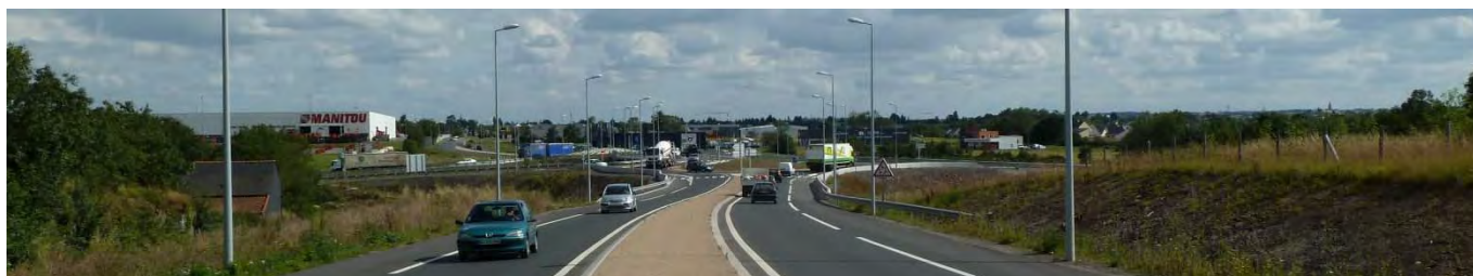
2 - Le nouvel échangeur de l'Aubinière
