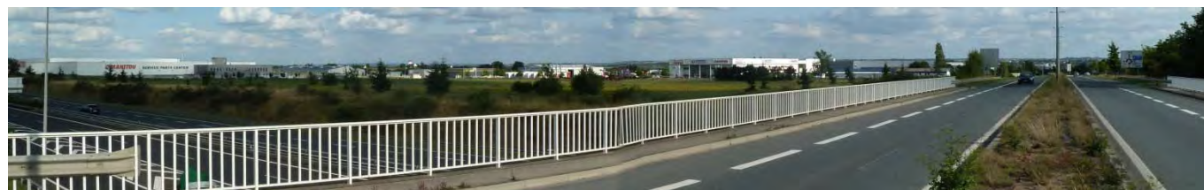
5 - Vue depuis l'A11 : l'usine Manitou et le site de La Savinière à l'approche du péage depuis Angers
