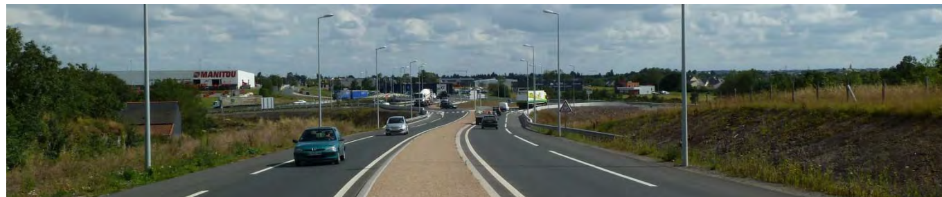
2 - Le nouvel échangeur de l'Aubinière
