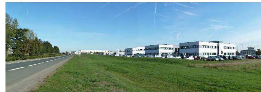
1 - Façade du quartier de l'Aéroport sur la RD 923
