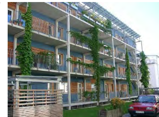
bâtiment passif – façade nord
