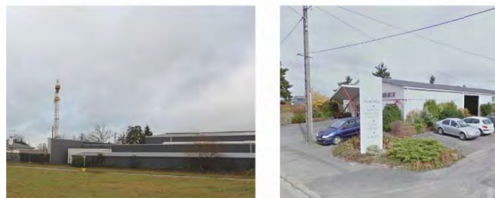
5 bâtiment de la toilerie au nord de la parcelle EM2
