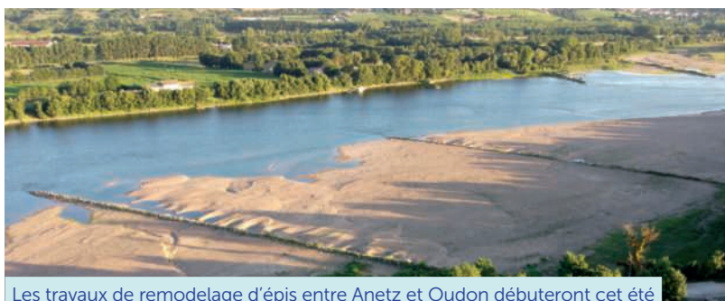
Les travaux de remodelage d'épis entre Anetz et Oudon débuteront cet été
